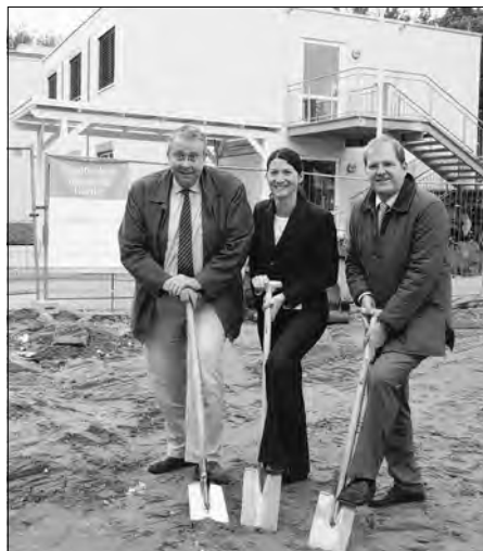
Der Aufsichtsratsvorsitzende Dr. Walter Oeckl (li.), Geschäftsführer René A. Bostelaar (re.) und die Geschäftsführerin der Physio-Ergotherapie Service Görlitz GmbH , Jeannine Cwikla geben mit dem Spatenstich den Startschuss zum Bau.
