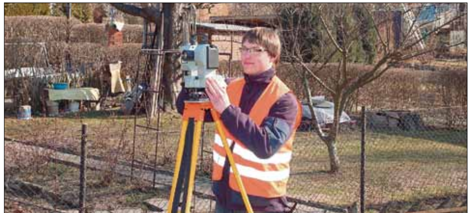
Tobias Emme, Auszubildender 3. Lehrjahr, bei Vermessungsarbeiten auf der Parsevalstraße
