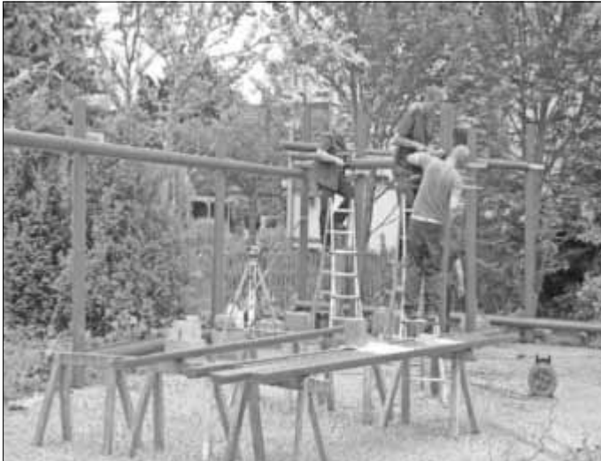
Mitarbeiter der Altenburger Firma „Pro Kid“ montieren die Pergola im Pontegarten
