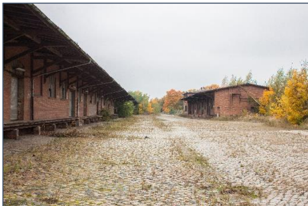
Abb. 18: Ehemaliger Güterbahnhof vor der Sanierung
