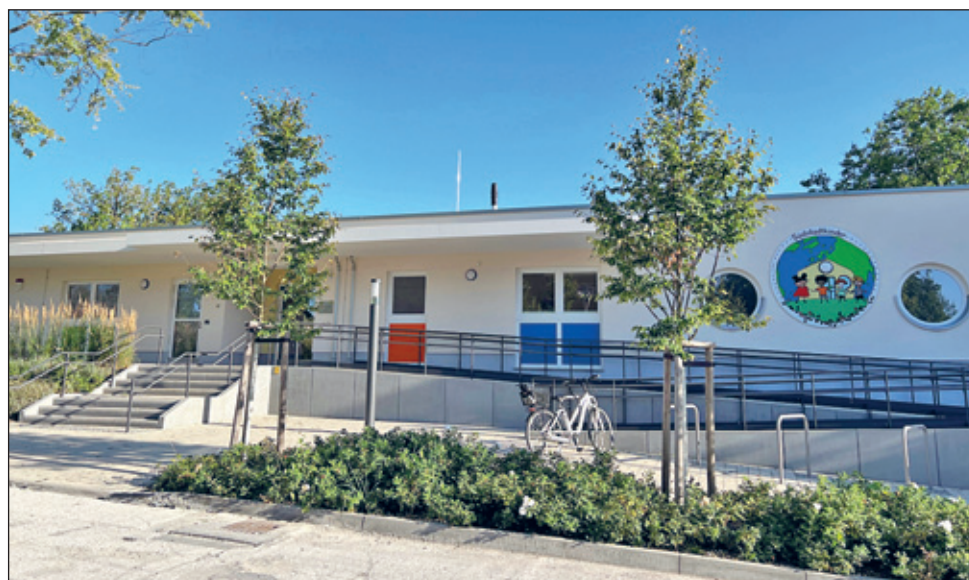
Kitagebäude auf der Fichtestraße
